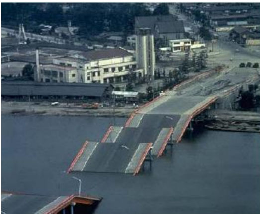
Figure 7 Effondrement des tabliers
