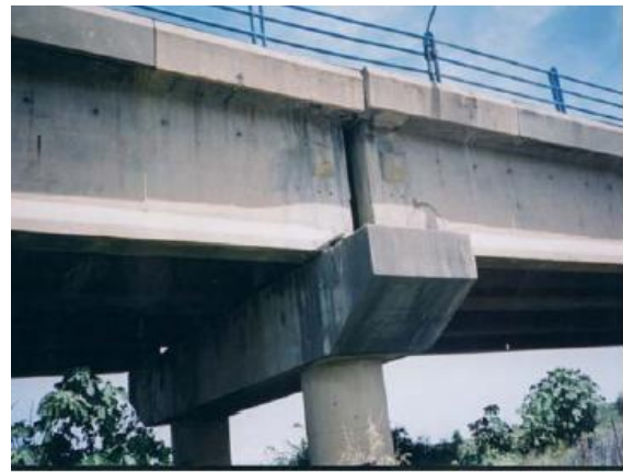
Figure 6 Déplacement latéral et longitudinal
