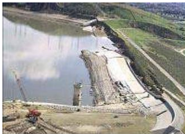
Figure 4 effondrement du parement amont du barrage de San Fernando pendant Le séisme de 1971
