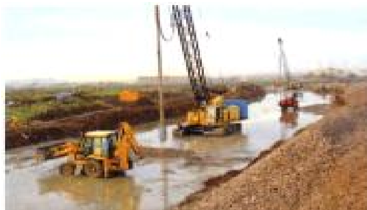
Figure 1 Colonnes exécutées par voie humide
