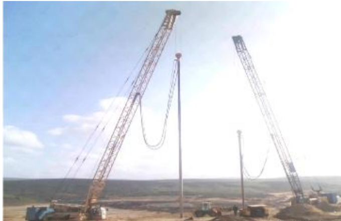
Figure 3 Chantier de vibrocompactage (barrage sur l'oued -Harka- Tunisie)
