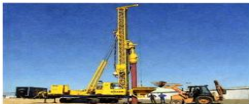
Figure 2 L'atelier de colonnes ballastées voie sèche (Construction d'une Fromagerie BEL à Kolea)
