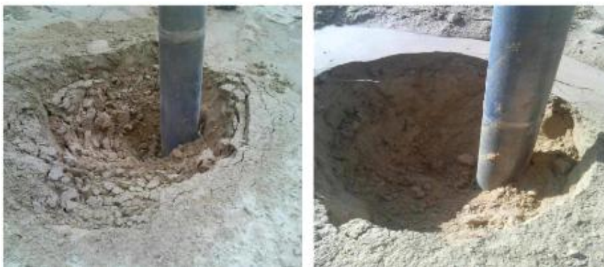
Figure 7 Le cône d'affaissement autour de vibreur (barrage -Harka- TUNISIE).
